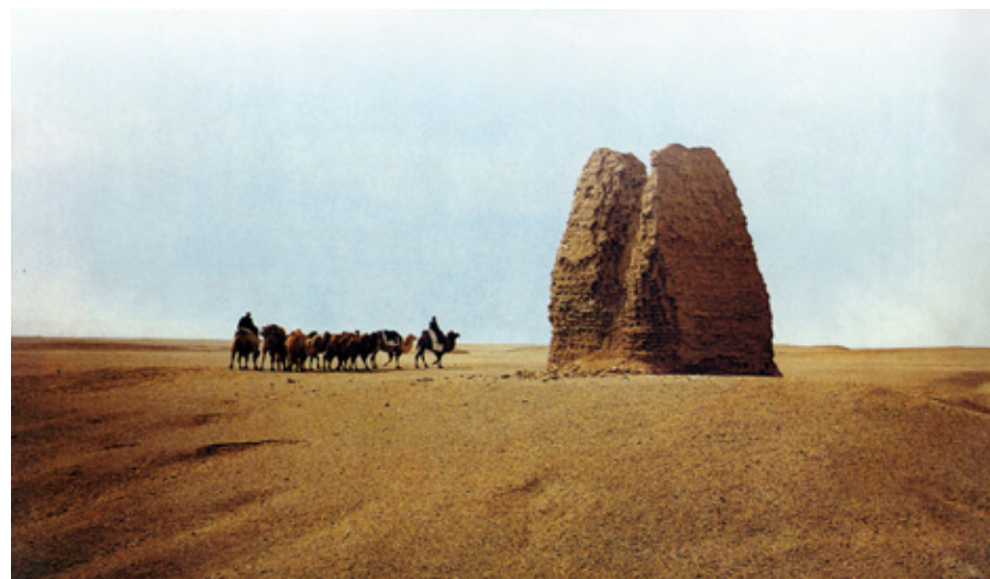
丝绸之路上的烽火台
