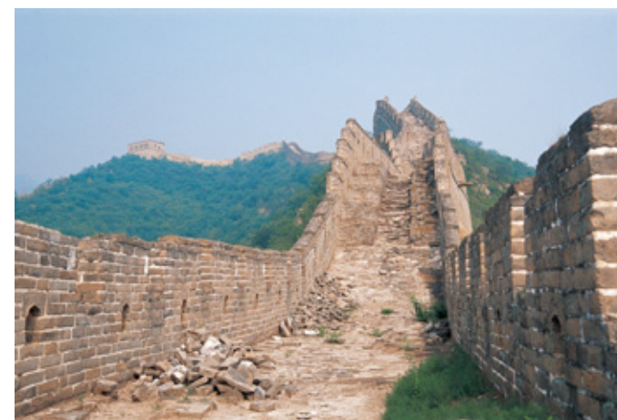
北京司马台明长城的空心敌台和过涧障墙
