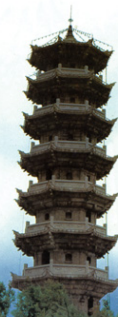
福建长乐三峰寺塔，是郑和船队出入港口的航标塔。
